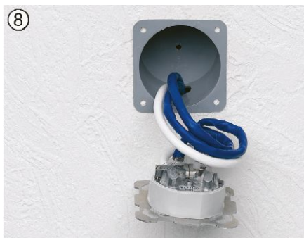
8 Kabelreserve eindrehen und Dose einbauen.
